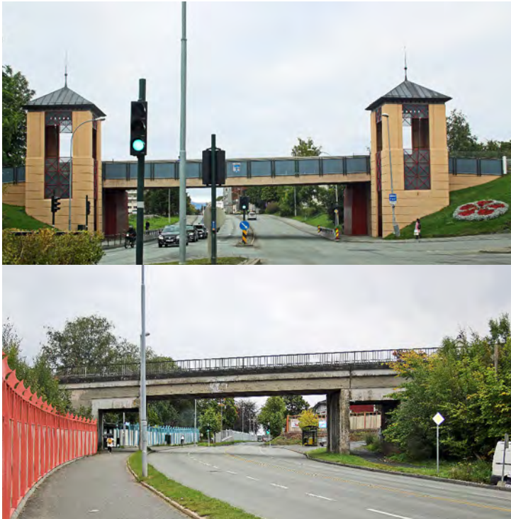
To bruer: Bildene viser to av de kjente bruene langs Stavnne-Leangenbanen. Øverst ser vi Byporten, brua over Holtermanns veg ved Lerkendal. Den er 23,5 meter lang. Nederst ser vi brua over Innherredsveien ved Saxenborg allé. Den er 42 meter lang. Foto: Hermann Hansen.
