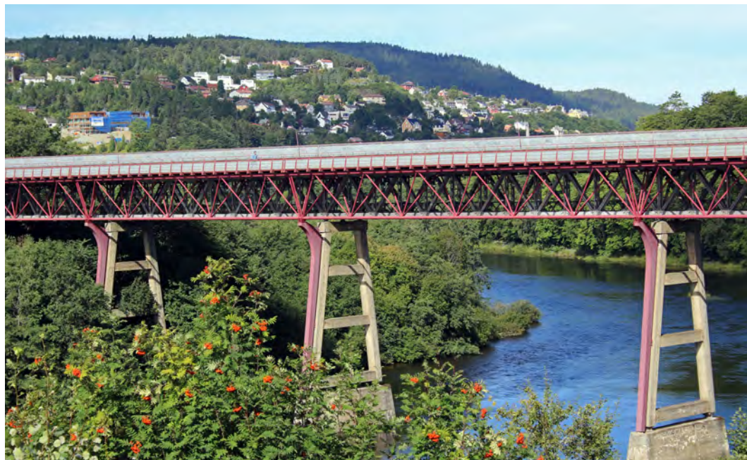
Dagens bru: Stavnebrua slik den fremstår i dag, 186 meter lang og med en tre meter bred gangbane. På vestsiden er sporene på Dovrebanen nordfra og sørfra koblet sammen like ved brua.
